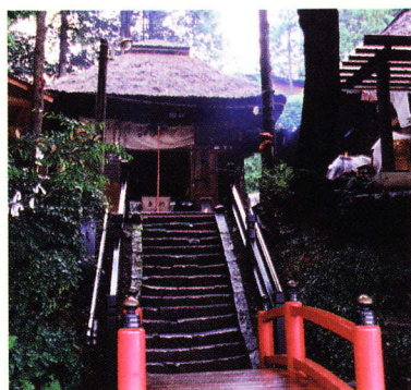
浅間山噴火の際、避難所となった鎌原(かんばら)観音堂(群馬県嬭恋村)。150段余あったとされる石段は泥流に飲み込まれ、15段が残る。
